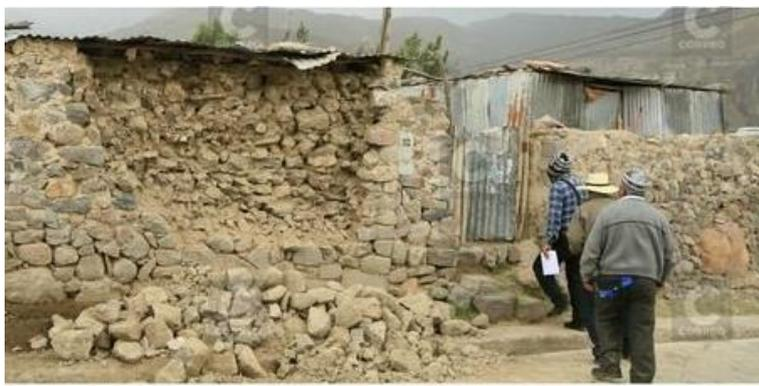
**Figura 2.** Vivienda de la zona de maca afectada por el sacudimiento generado durante el enjambre sísmico, registrado el 20 de febrero de 2016. (Fuente Correo).
