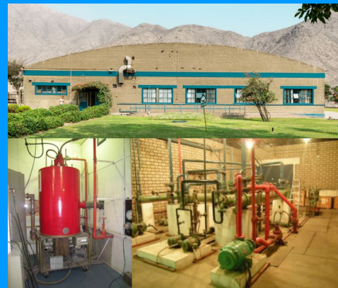
Figura 3. Edificio principal del Radio Observatorio de Jicamarca donde se encuentran los transmisores que alimentan al radar principal.
