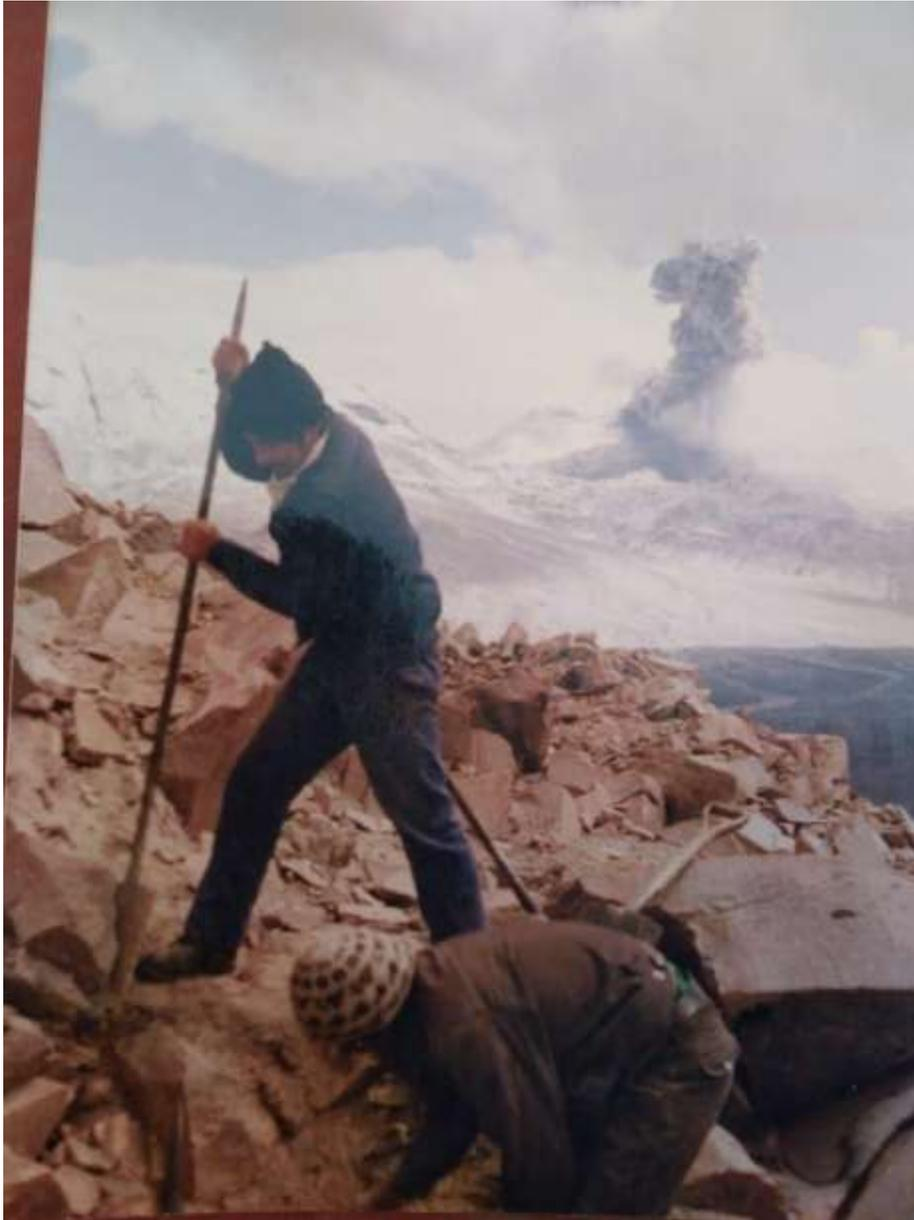
*Figura 1.- Año 1988: Técnicos Victor Montesinos y Rider Navarro del IGP preparando el terreno para la construcción del pozo de tierra junto a la estación sísmica de Jolla Jello. Al fondo el volcán Sabancaya en erupción emitiendo fumarolas.*
